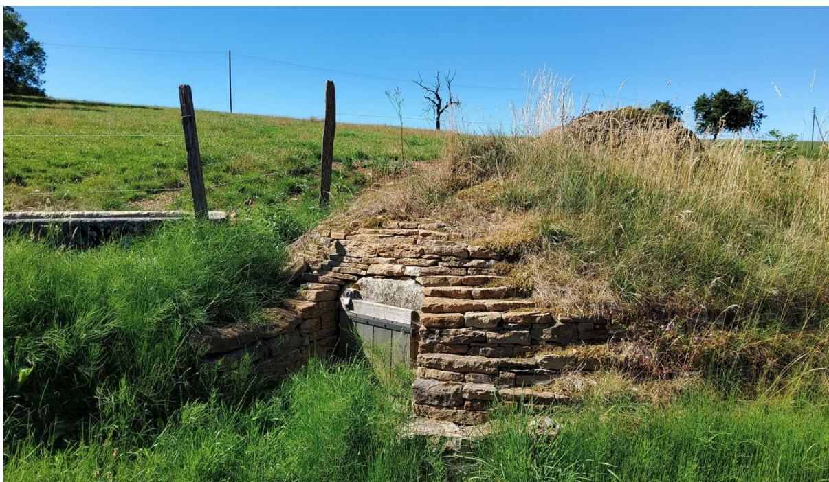
Figure 6 - Citerne rénovée du Clos des Citernes à Epiquez
