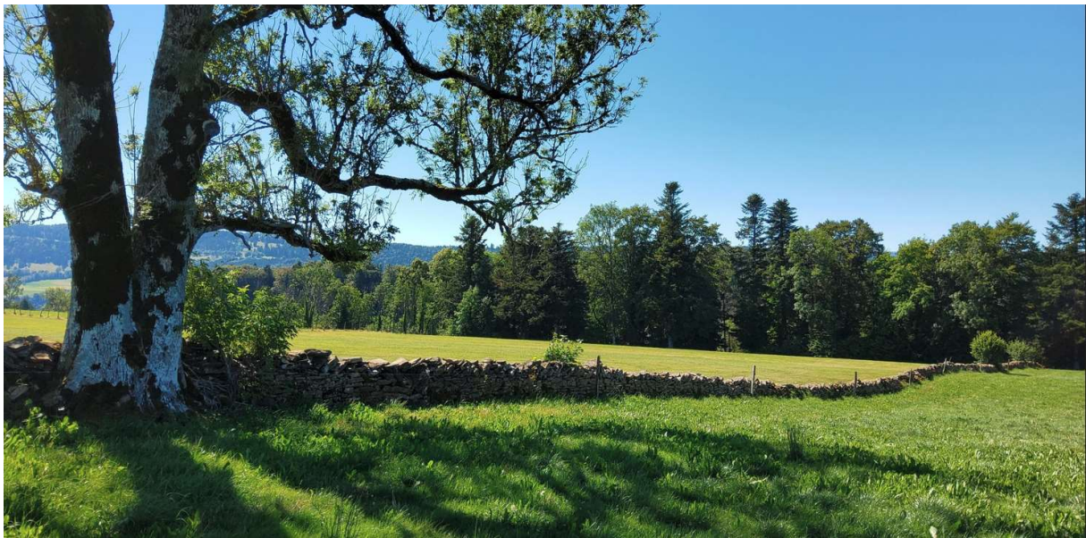
Figure 17 - Mur en pierre sèche des Prés Chaicos à Epiquez
